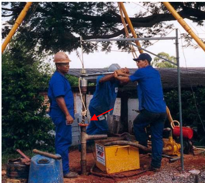
FIGURA 23 - Disco-centralizador utilizado no sistema de lavagem
