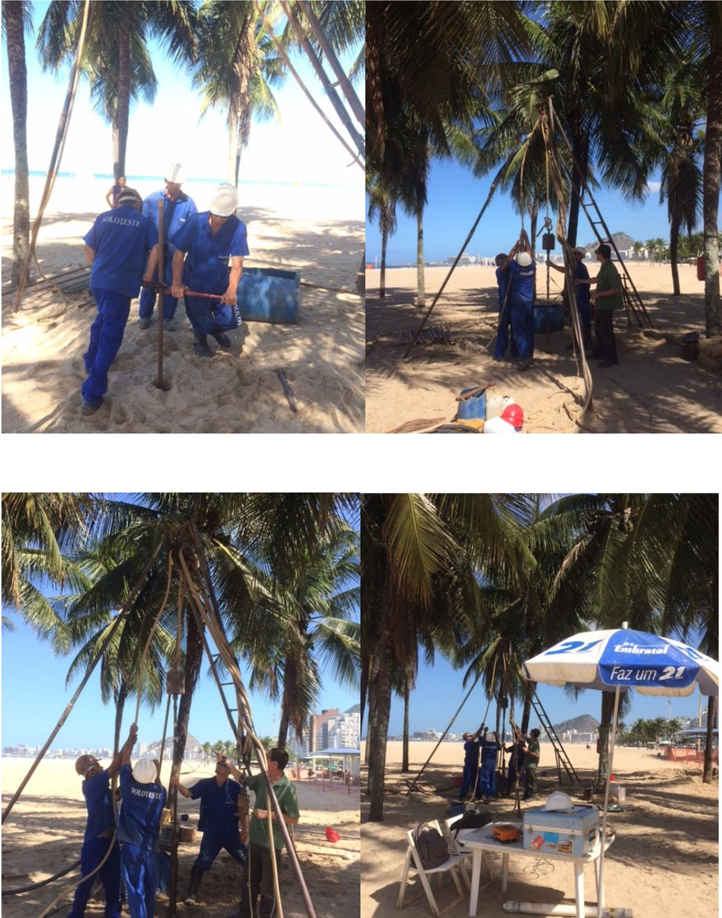
Figs. 4.4.a a 4.4.d – Etapas da sondagem SP01 em execução: (a) avanço da sondagem com utilização do trado-concha (antes do NA); (b), (c) realização do ensaio SPT com haste instrumentada; (d) vista geral do ensaio em execução e o sistema de aquisição de dados em funcionamento.
