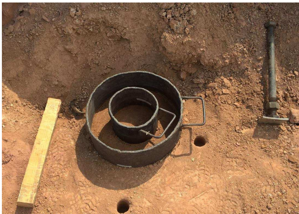
Figura 41: Instalação dos anéis.
