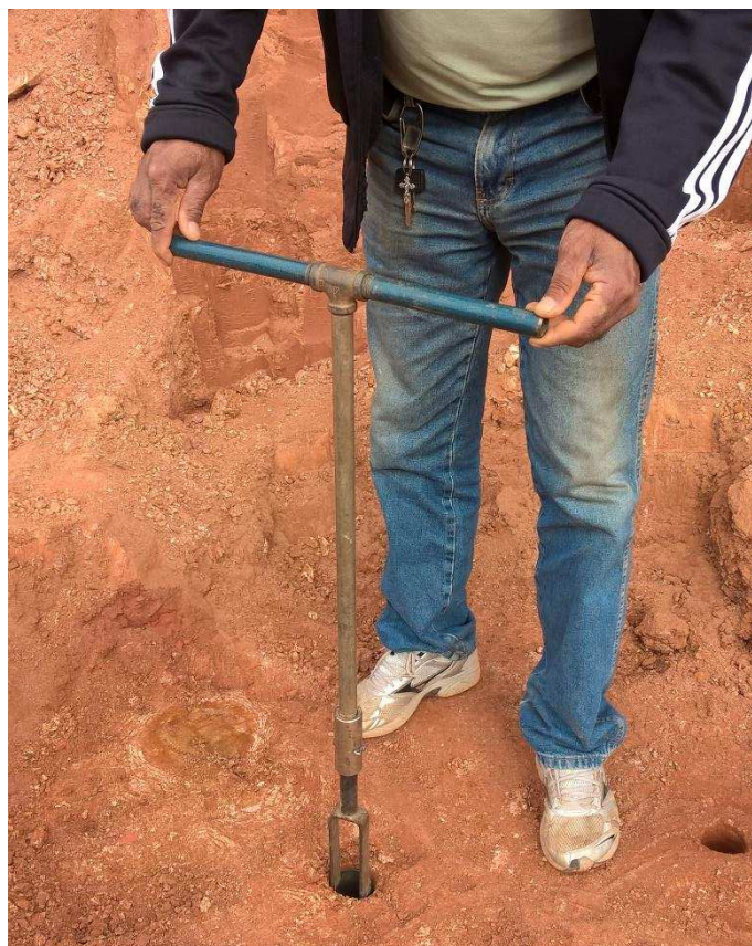
Figura 50: Escavação do furo com o trado manual.
