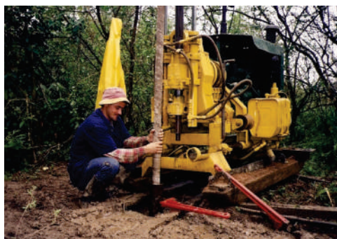
Figura 32 – Sondagem rotativa: instalação de piezômetro.
