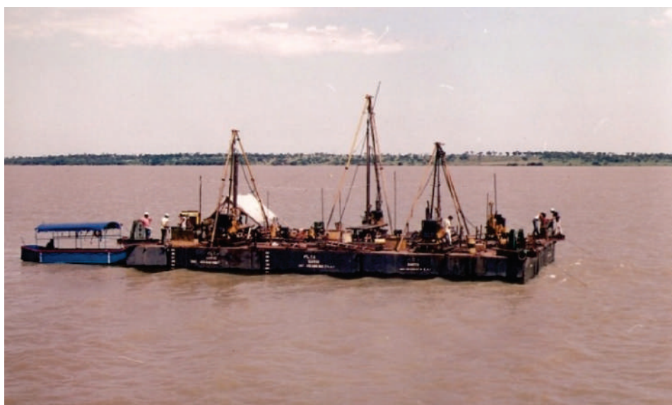
Figura 34 – Sondagem rotativa em balsa no Rio Paraná.
