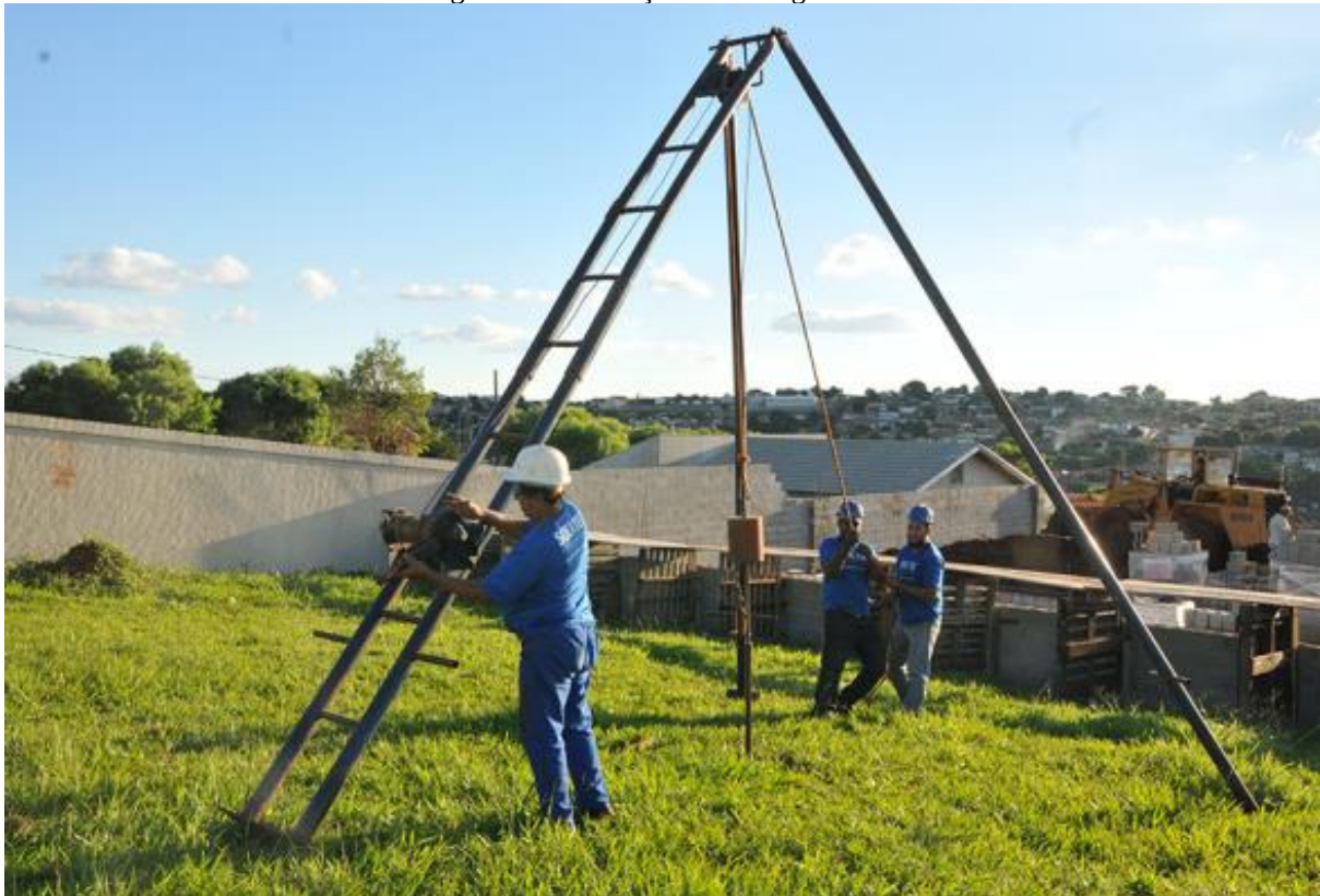
Figura 10: Realização da sondagem SPT
