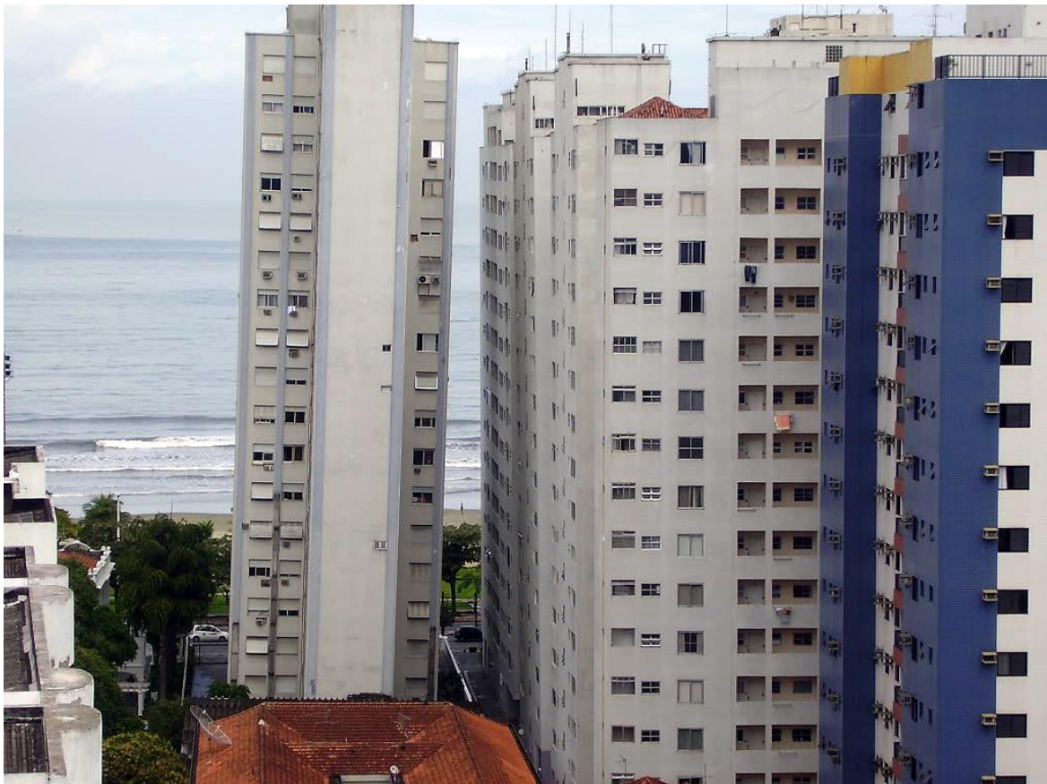
Figura 5: Prédio com recalque na praia de Santos
