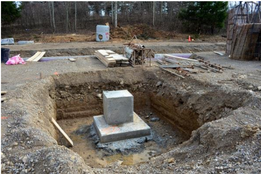
Figura 6: Fundação superficial (sapata)
