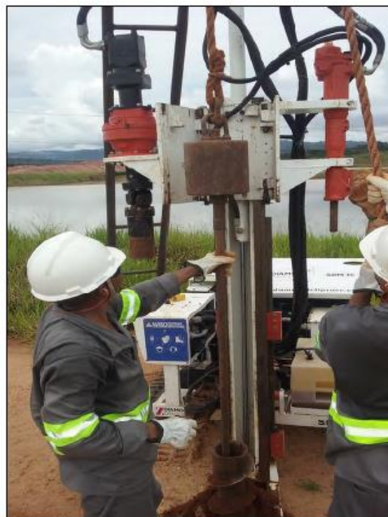
Foto 2 – Execução do ensaio de SPT por dentro da haste
