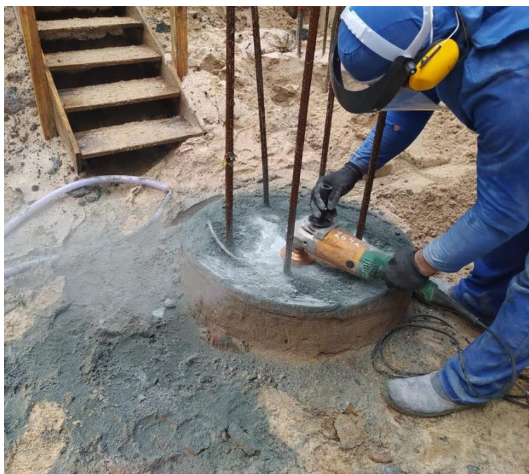
Figura 21 – Processo de preparação da estaca para o ensaio PIT
