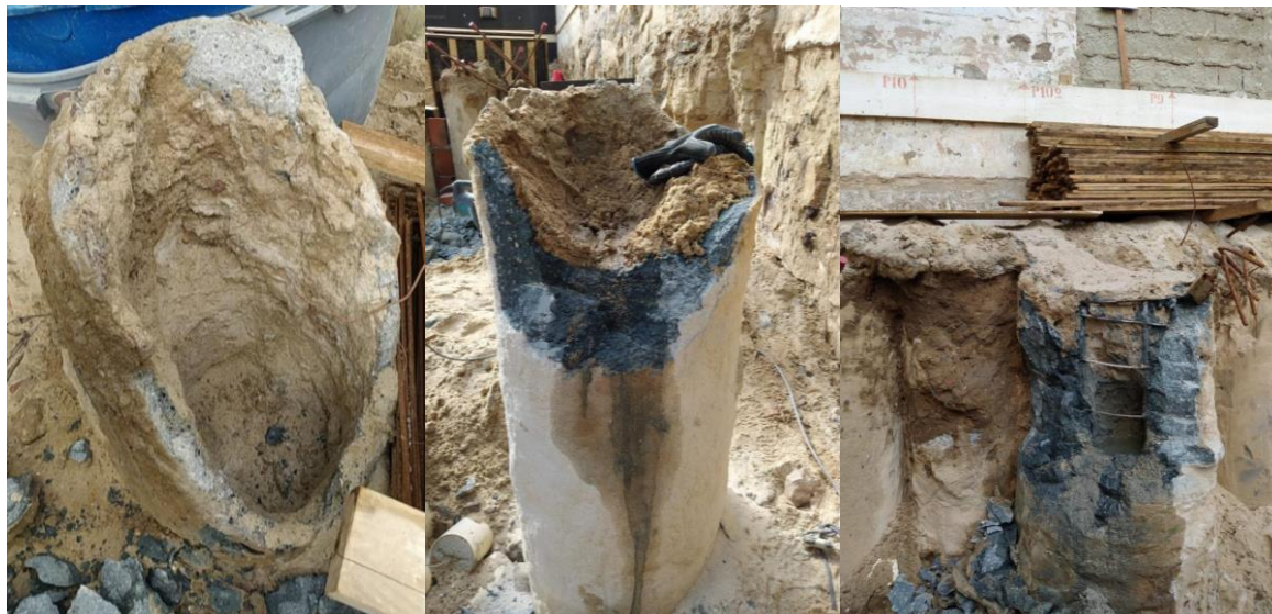
Figura 27 - Estacas com areia/solo no seu interior
