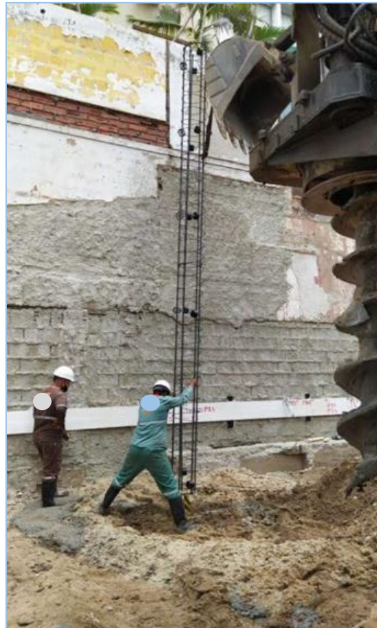
Figura 6 – Instalação da armadura
